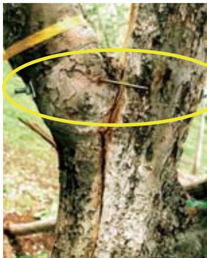
写真 43 ボルト、カスガイによる固定状況
