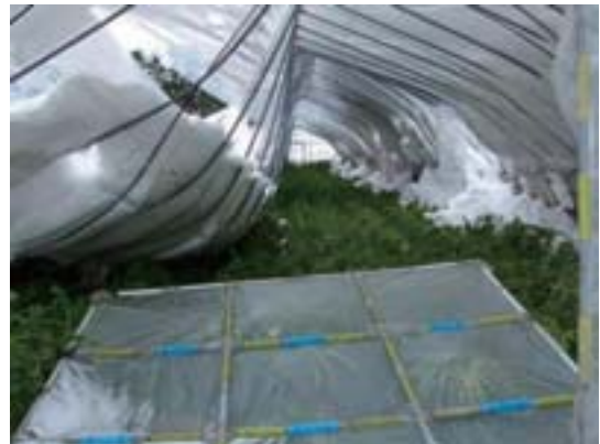
写真46 倒壊したハウスの状況 (内側)
