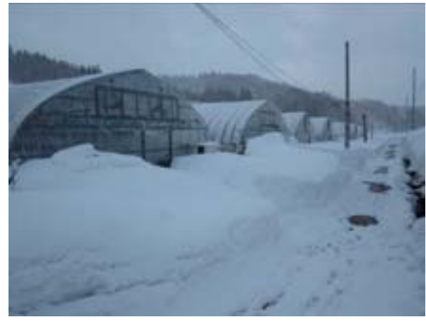
写真 19 暖房機を稼動し、屋根面の雪を滑落させているハウス
