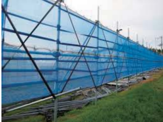
写真 22 野菜栽培ハウス周囲に防風ネットを設置している状況
