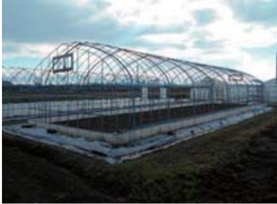
写真 9 被覆資材を除去したハウス
