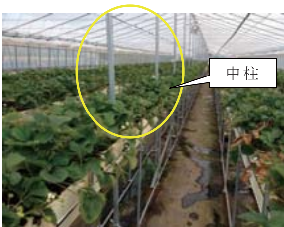
写真 11 補強用の中柱を設置したハウス
