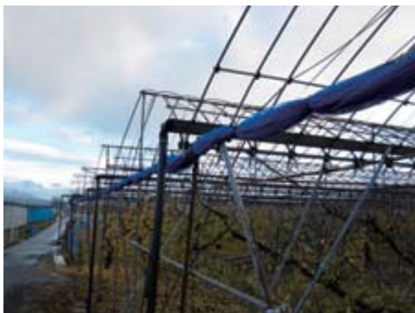
写真6 防風ネットをまとめた状況
