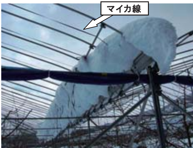
写真4 おうとう雨よけ施設の雨樋への積雪状況(マイカ線が張られたままのため、そこに積雪の塊が大きくなっている)
