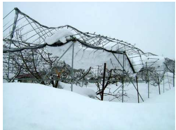
写真5 おうとう雨よけ施設のパイプ交差部への積雪状況
