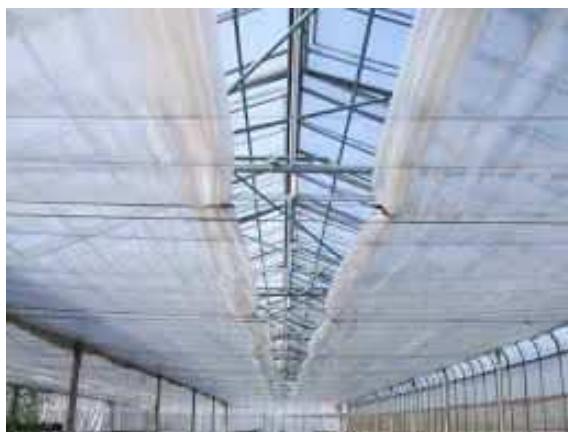
写真 33 内張りカーテンを開放し、屋根面の融雪を促す
