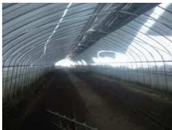
写真 34 無加温ハウスで、ハウス密閉により屋根面の雪が滑落している状況
