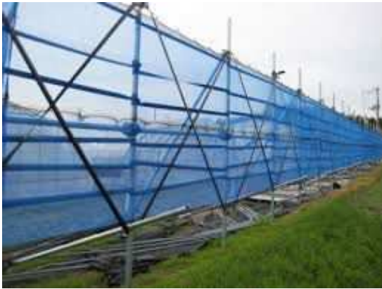
写真 22 野菜栽培ハウス周囲に防風ネットを設置している状況
