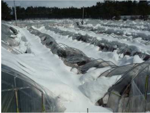
写真45 倒壊したハウスの状況 （外側）
