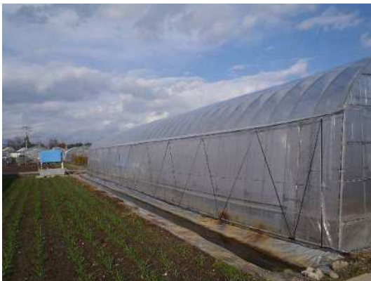
写真 16 ハウス外側に溝を掘り、ビニル等を敷設した状況
