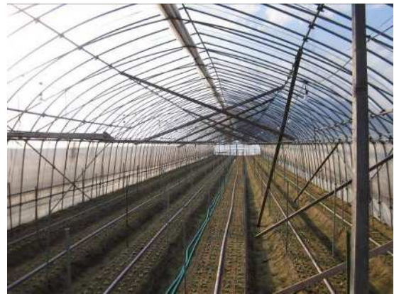
写真 14 角材を用いて筋交い補強をしたハウス
