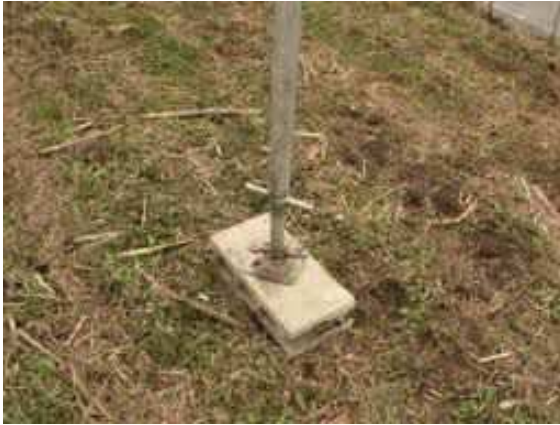
写真 15 中柱の沈み込みを抑えるためブロックを台石として設置
