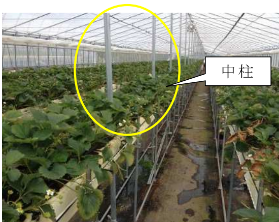
写真 11 補強用の中柱を設置したハウス
