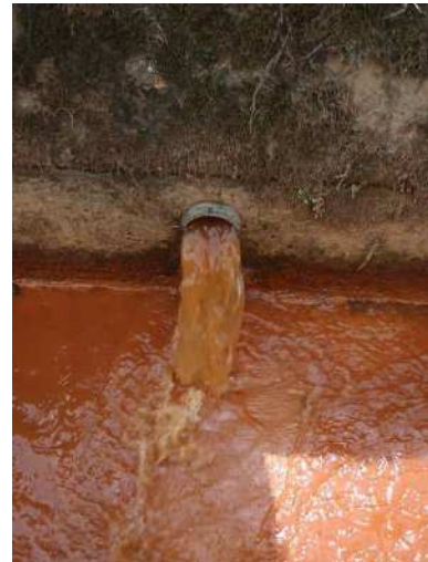
写真8 暗きよの排水口の状況を確認
