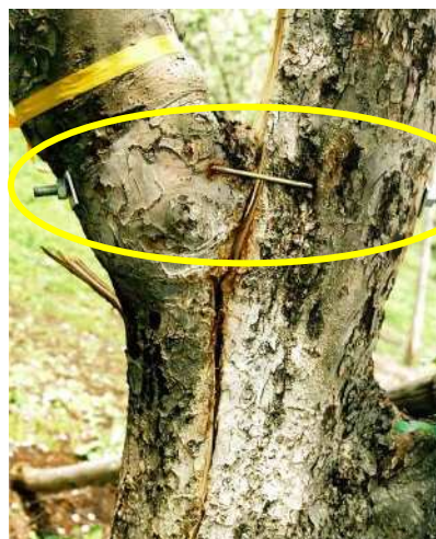
写真 43 ボルト、カスガイによる固定状況
