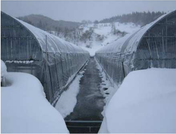
写真 18 屋根面から滑落した雪を地下水で消雪している状況
