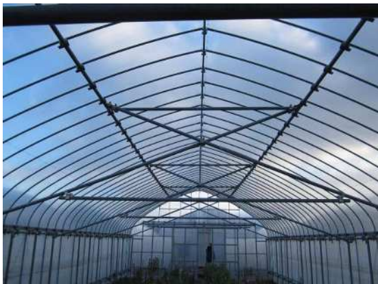
写真 13 パイプを用いてハウスを補強している状況
