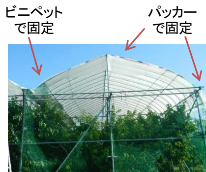
■ 遮光資材の設置例
