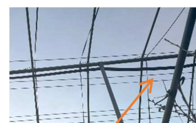
■ 散水チューブを峰下に吊り下げて設置
