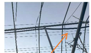
■ 散水チューブを峰下に吊り下げて設置
