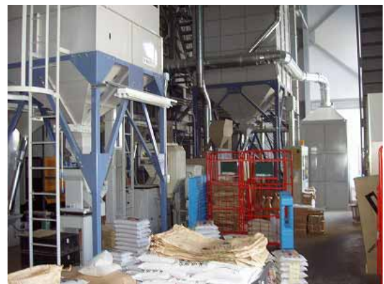
乾燥調製貯蔵施設（内部）
