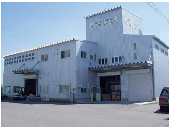
乾燥調製貯蔵施設（外観）
