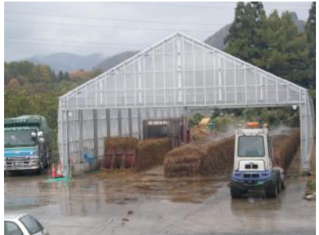
高品質堆肥製造施設
