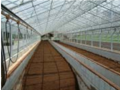
深型攪拌方式を複数層備えた堆肥センターの事例。
